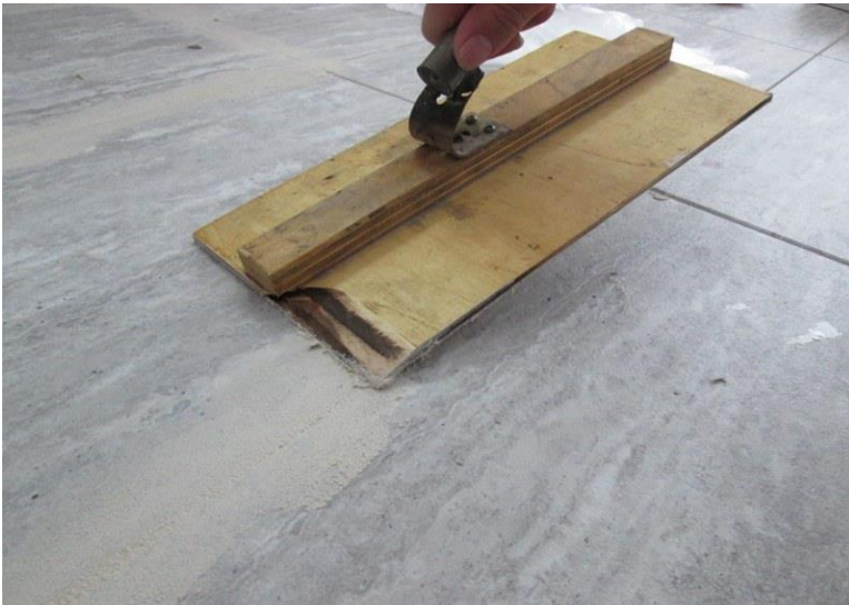
Fig. 2 - Faire pénétrer le coulis dans les joints
